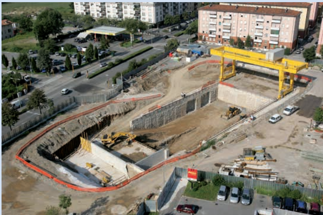
Il cantiere per la creazione della stazione Lamarmora della metropolitana di Brescia, nel 2005.
