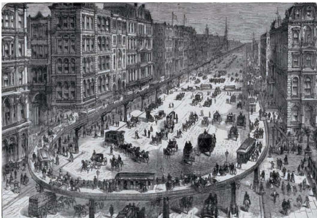
Strada sopraelevata ottocentesca in una metropoli ottocentesca. L'uso di tre livelli di traffico si insinuò rapidamente nelle strategie del trasporto urbano.
