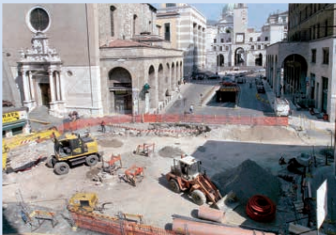
Inizio degli scavi per la costruzione della stazione Vittoria della metropolitana di Brescia (2006). Oggi il panorama è alquanto mutato.
